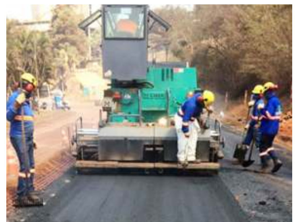
Aplicação de CBUQ com rejeito arenoso na pavimentação de estradas - Foto - Unifei
